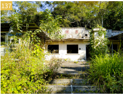
圖 137：主校舍和籃球場之間有水平差別，倡議人應考慮增設無障礙通道
