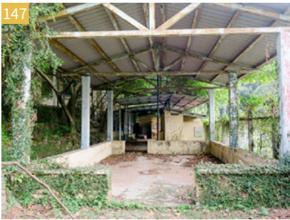
圖 147 及 148：內部情況—地下的有蓋操場及洗手間
