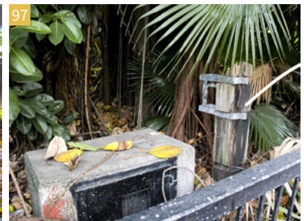
圖 97：用地的內部—有供水設施
