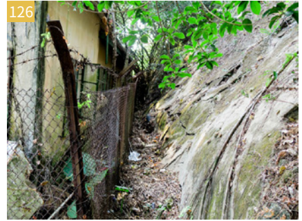
圖 126：校舍背靠斜坡，需注意斜坡安全
